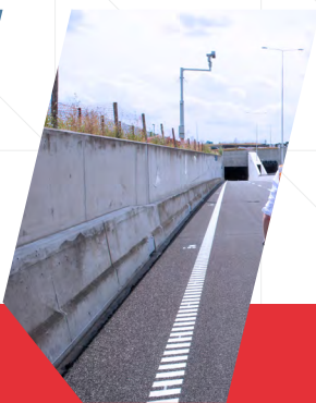
Beton en Staal
